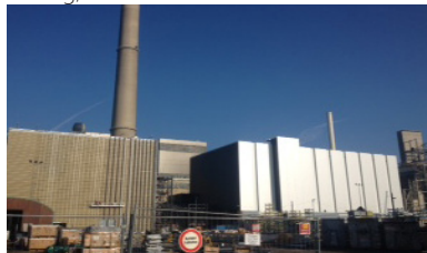
Kraftwerk Lausward, Deutschland
