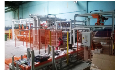
Kronospan, Polen Verbindung der neuen Technologien
