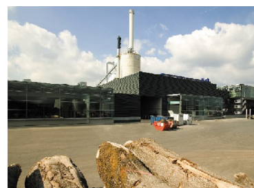
Pollmeire Creuzburg, Deutschland Holzbearbeitungsbetrieb- Installation der neuen Technologien
