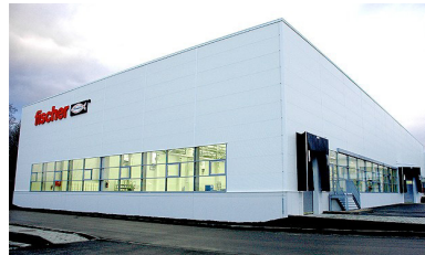
Produktionshalle Fischer, Ivanovice na Hané, Tschechien; komplette Elektroinstallation-Arbeiten in der neuen Halle, einschliesslich Beleuchtung, Blitzbleiter
