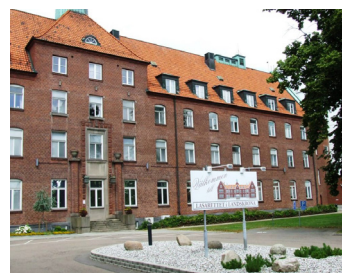
Krankenhaus Landskrona, Schweden Rekonstruktion der Elektroinstallation
