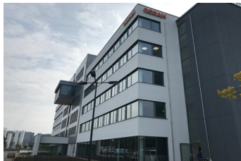
Osram Regensburg, Deutschland Komplette Elektroinstallation
