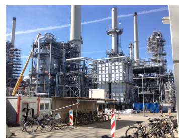
Raffinerie Bayernoil, Deutschland Elektroinstallation-Arbeiten, Rekonstruktion, neue Installation bei der Stilllegung von Raffinerie
